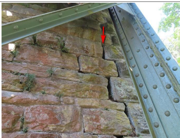
Foto č. 9 - O 02 - závěrná zeď z čela vpravo, odpojení rohových kvádrů svislou trhlinou ve spáře, hrozí rozvíjení poruchy.
