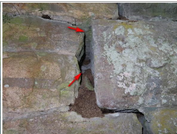
Foto č. 10 - O 02 - závěrná zeď z čela vpravo detail, spára je bez pojiva do hl. až 400 mm. Ve spáře pouze písek.
