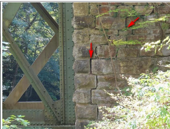
Foto č. 8 - O 02 - závěrná zeď z líce vpravo, odpojení rohových kvádrů svislou trhlinou ve spáře, hrozí rozvíjení poruchy. Křídlo má hloubkově vypadané spárování.
